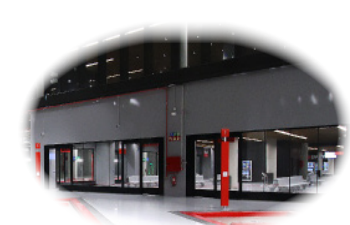
Intercambiador estación autobuses termibus (Bilbao)
