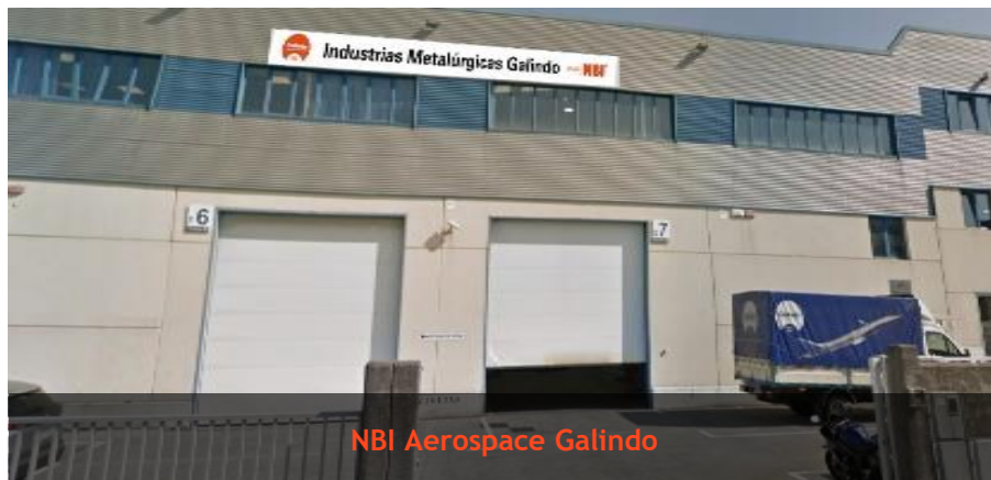
Planta, almacén y oficina ubicadas en Munguía
